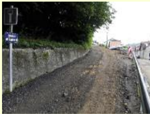
L'impasse Mine d'Angevillers avait bien mérité une restauration complète.
