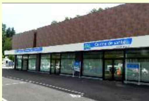
Le nouveau dispensaire de la CARMi occupe une grande partie du nouveau bâtiment sur le site de la Paix du haut
