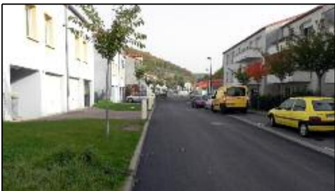
La rue des Peupliers a fait peau neuve, grâce aux efforts de la municipalité. En effet celle-ci a exigé, avant toute reprise dans le domaine communal, que le bailleur LOGIEST, remette en état et aux normes en vigueur la chaussée dégradée de cette rue.
